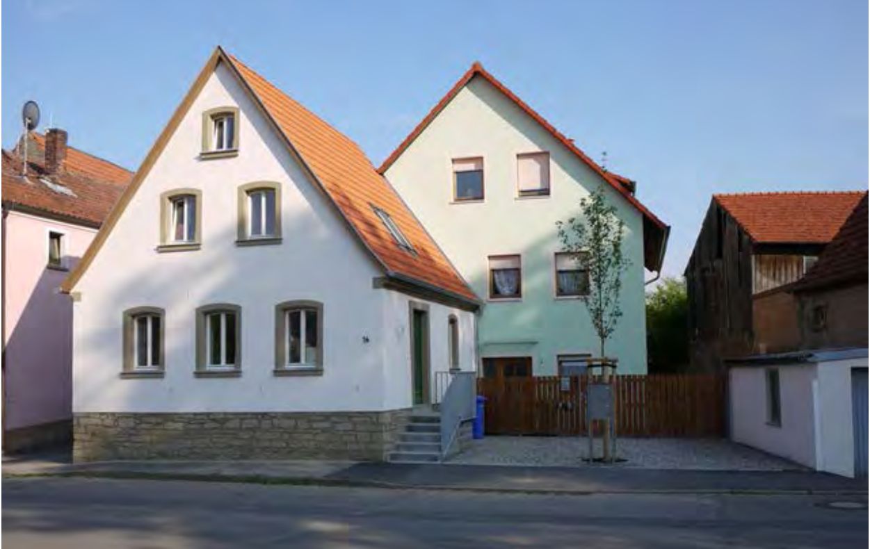
... und nach der Sanierung von außen...
