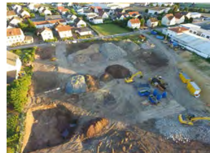
Nach dem Abbruch Fotos © Gemeinde Salz
