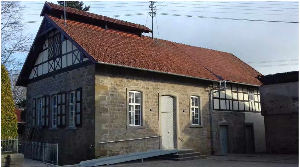
Nach der Sanierung © Gemeinde-Allianz „Hofheimer Land e.V.“
